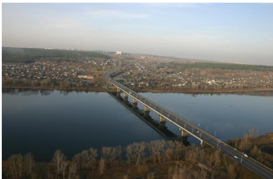
Рисунок 3. Мост Искитимский (через реку Большая камышная)
